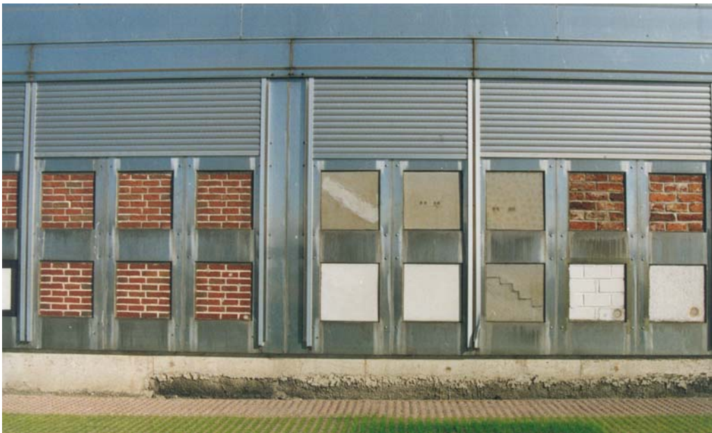
Bild 8 Aufnahme der Westfassade der klimatisierten Testhalle auf dem Versuchsgelände in Holzkirchen mit den eingebauten Mauerwerkselementen.
